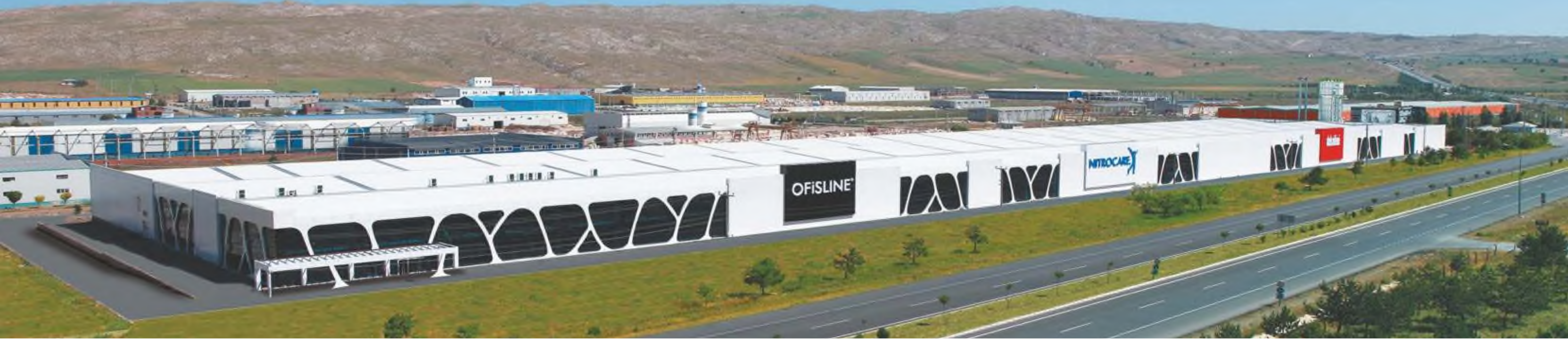
OFİSLINE FABRİKA / OFISLINE FACTORY
